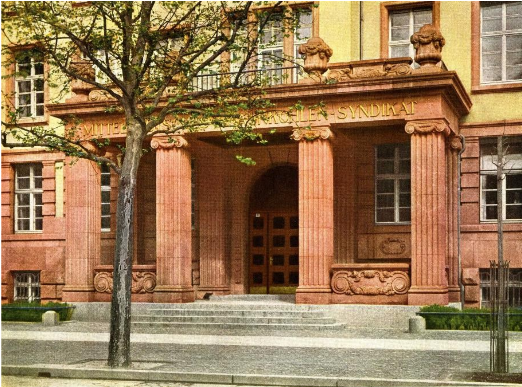
Haupteingang zum Verwaltungsgebäude des Mitteldeutschen Braunkohlen-Syndikates in Leipzig, erb. 1921/22
